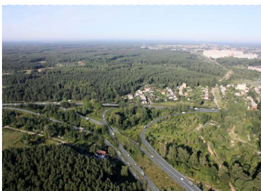
4.att. J.Čakstes gatves un Ziepniekkalna ielas šķērsojums 2012.
