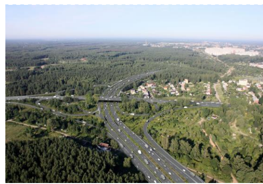
5.att. J.Čakstes gatves un Ziepniekkalna ielas šķērsojums pēc pieslēguma izbūves līdz Vienības gatvei.
